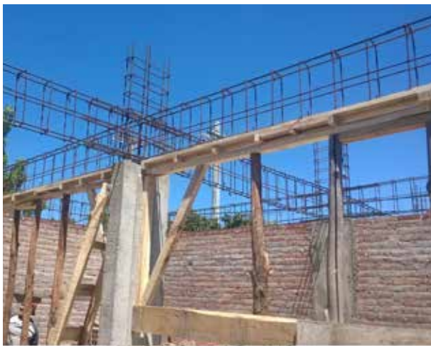
Viga de carga
